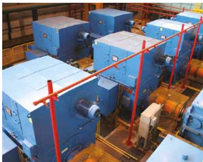
Motores sincrónicos SDL800, 3.000 kW, 3.100 V Aplicación: Laminadoras (siderurgia)
