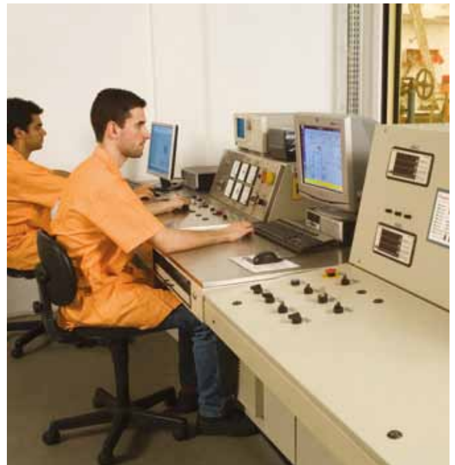
Sala de control
