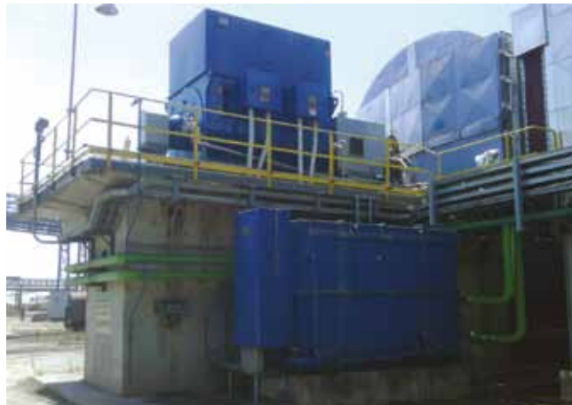
Suministro: 9.000 kW, 6.600 V, 8 polos, carcasa 900 Aplicación: Extractor
