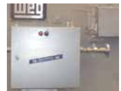
Sistema de presurización para área clasificada
