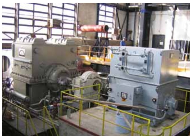
Suministro: 12.000 kW, 6.000 V, 4 polos, carcasa 800 Aplicación: Compresor centrífugo
