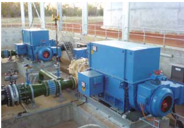
Suministro: 2.000 kW, 11.000 V, 4 polos, carcasa 560 Aplicación: Bomba de agua
